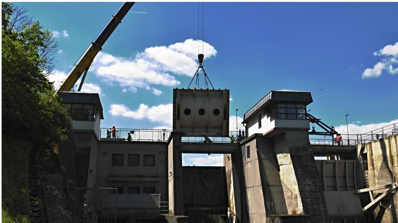
Jezová klapka o délce 7 metrů a výšce 6 metrů byla jako nadměrný náklad převezena do Mělníka do dílen zhotovitelské společnosti MVS Walter s.r.o. Na uzávěru proběhne demontáž zbývajících částí čepů a osazení nových čepů včetně prvků pro jejich uložení. Dále se obnoví protikorozní nátěr a vymění se těsnicí prvky. Hodnota prací je 2,5 mil. Kč bez DPH.
